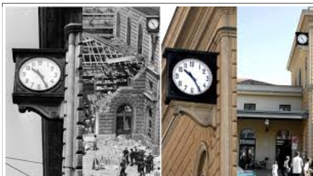
La stazione di Bologna nel 1980, dopo l'esplosione; la stazione al giorno d'oggi
