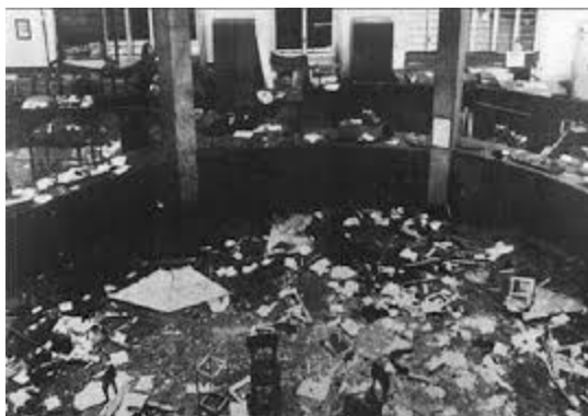
La voragine causata dall'esplosione nella Banca dell'Agricoltura
